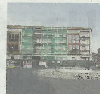
Travaux de ravalement en cours pour la future Maison de la Région à Saint-Gaudens.
